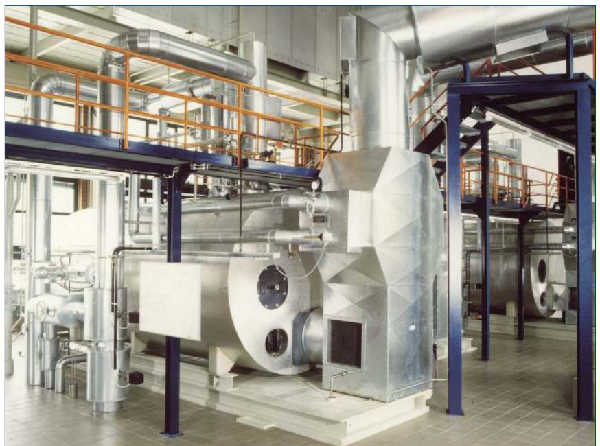
Рисунок 1: Паровой котел UNIVERSAL с Компакт-ECO-SA для паропроизводительности 1-28 т/ч.
